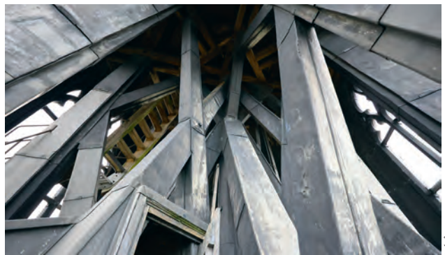
Vue de l'intérieur de la flèche. Sa construction nécessitait une grande maîtrise technique.
